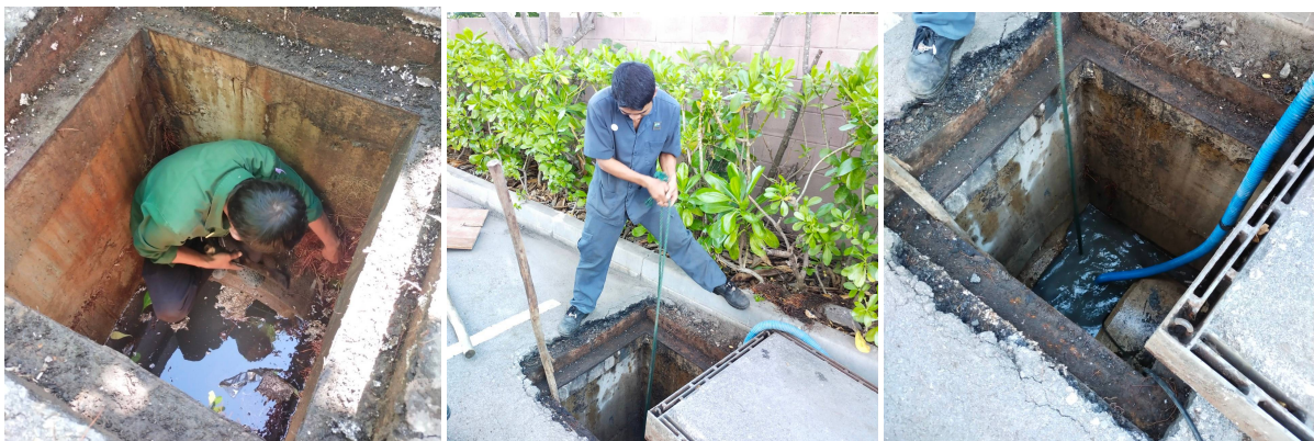
ภาพที่ 3-43 ขุดลอกท่อระบายน้ำ เอาเศษขยะออกทำให้การระบายน้ำได้ดี
