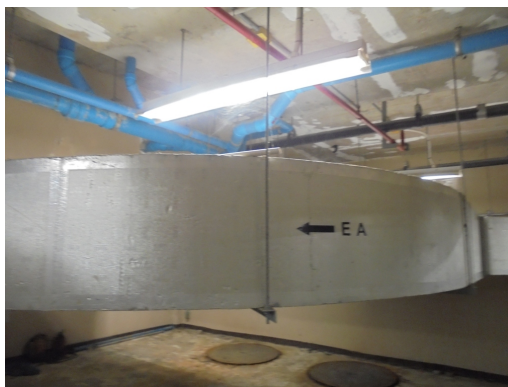
ภาพที่ 3-9 ท่อระบายอากาศที่ระบบบำบัดน้ำเสีย มีระบายอากาศดีเข้าและระบายอากาศออก
