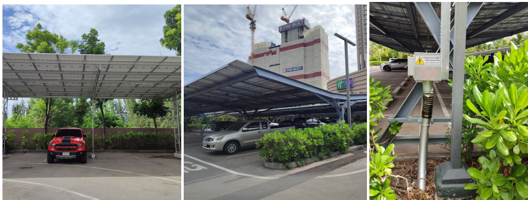
ภาพที่ 4-48 ติดแผงโซลาร์เซลล์ (พลังงานแสงอาทิตย์ไว้ที่หลังคาที่จอดรถยนต์ด้านหน้าโครงการ
