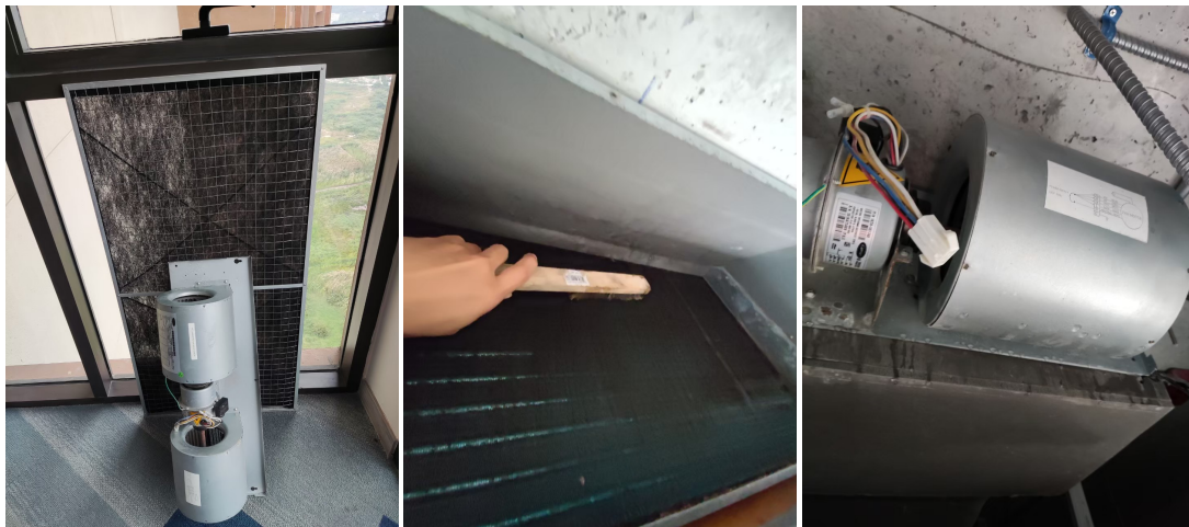
ภาพที่ 3-45 ดำเนินการทำความสะอาดระบบปรับอากาศของอาคาร
