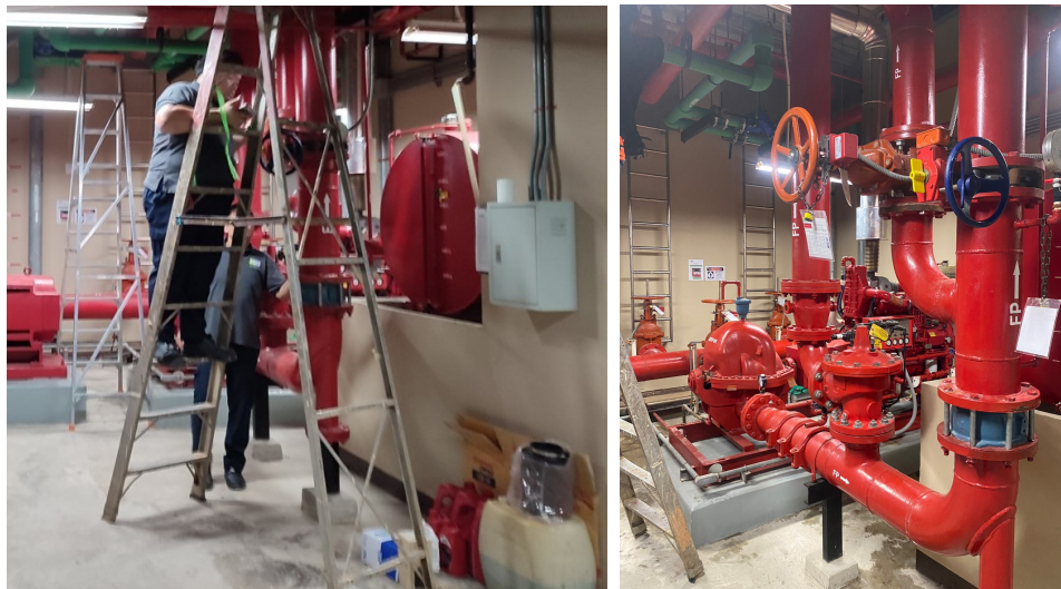
ภาพที่ 3-42 ตรวจสอบระบบ Fire Pump เป็นประจำทุกเดือน
